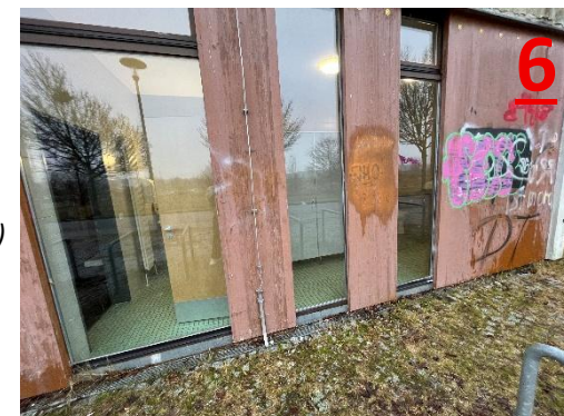
Toilettebereich vor dem Räumen der Sozialpädagog:innen (Turnhalle)
